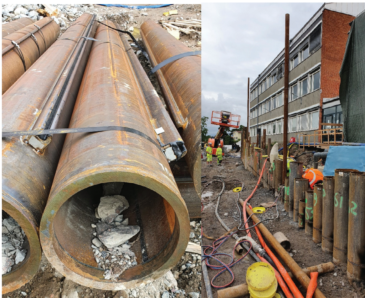
Figur 3. Rörpålar med spontlås och installation av rörpålevägg.
