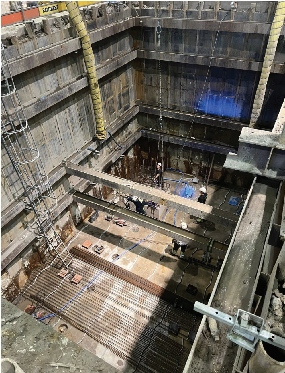
Figur 4. Spontgrop i silt/finsand tätad bakom spont och i schaktbotten.
