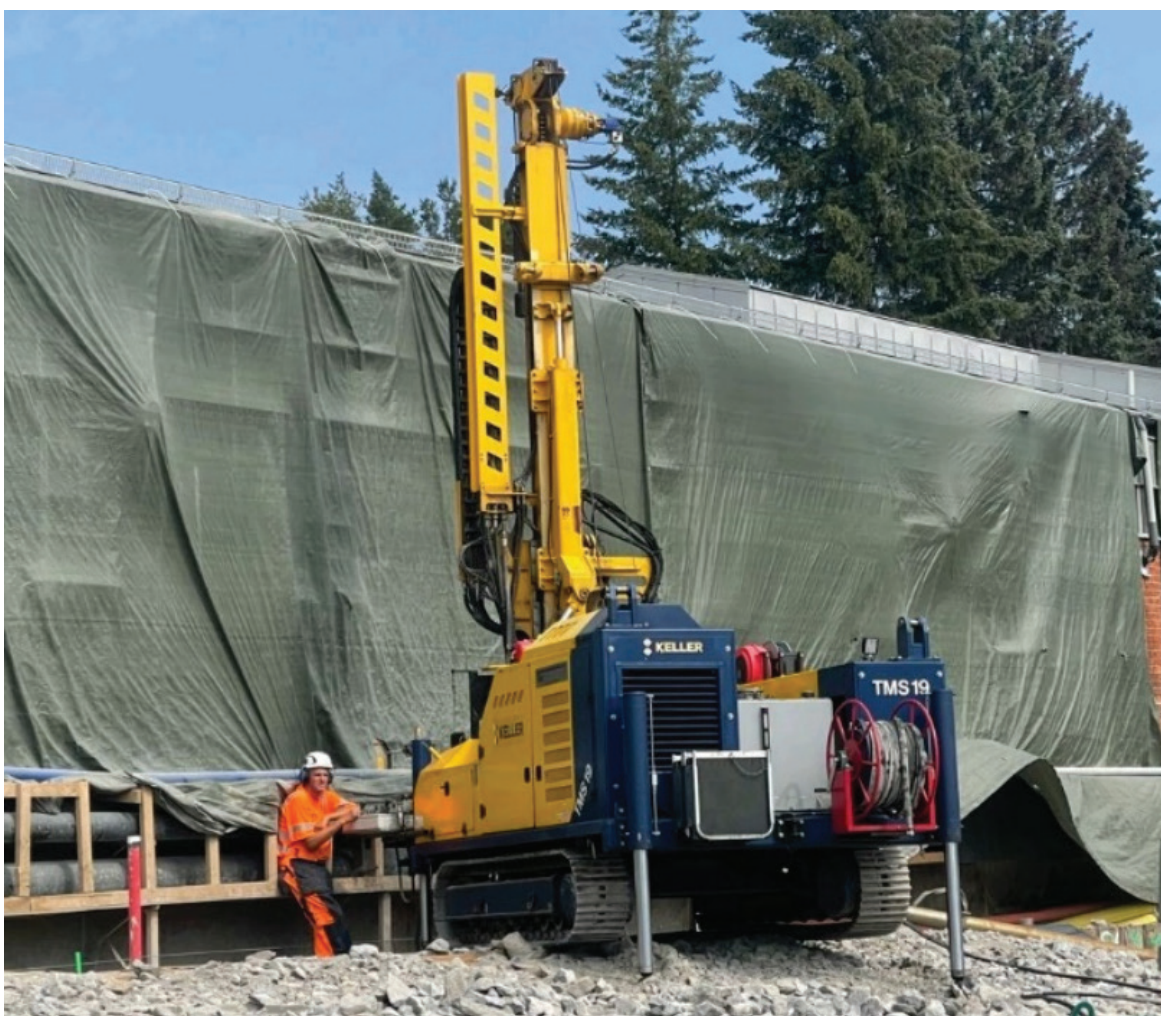
Figur 10. Pågående kärnborrprovtagning (Keller).
