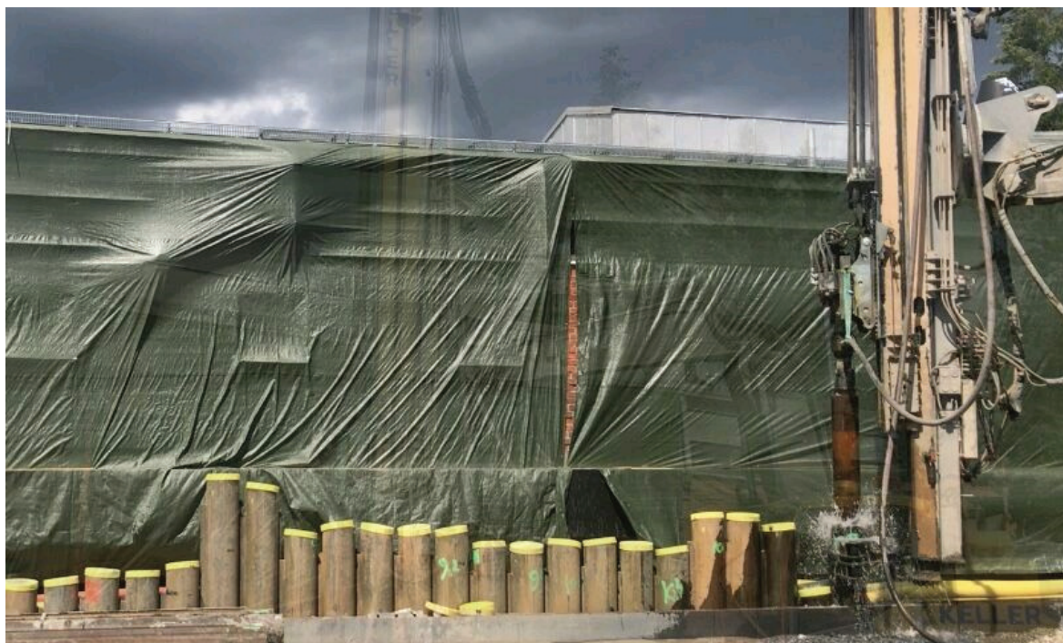
Figur 4. Installation av rörpålägg med vattendriven sänkborrhämmare.
