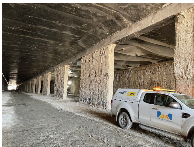
Figur 6. Bild inifrån tunnel i Åkarp efter framschaktande med top-down metod.
