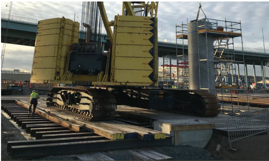
Figur 18 Bild som visar upplagskonstruktionen med Asobe-mattor och montagebalkar ovanpå de tvärgående HEB300-balkarna som är placerade på det översta lagret med stockmattor. Därunder finns ytterligare ett lager med stockmattor som är lagda med samma längdriktning som HEB-
