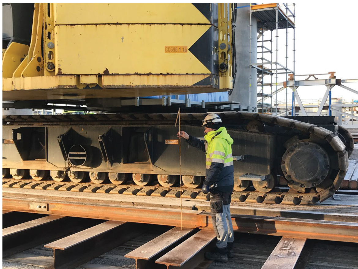
Figur 19 Avvägning vid provbelastning med larvkranen.
