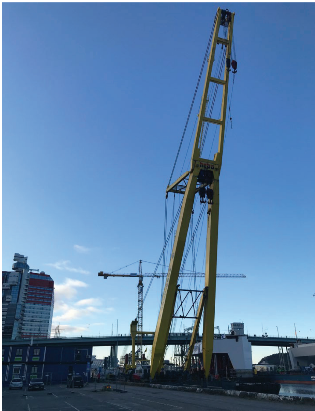
Figur 6 Pontonkranen Svanen som användes för lyft på Göta älv av broelement.
