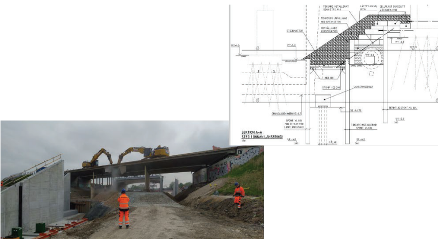
Figur 5. Skydd av spont och ledning i samband med rivning av motorvägsbro.
