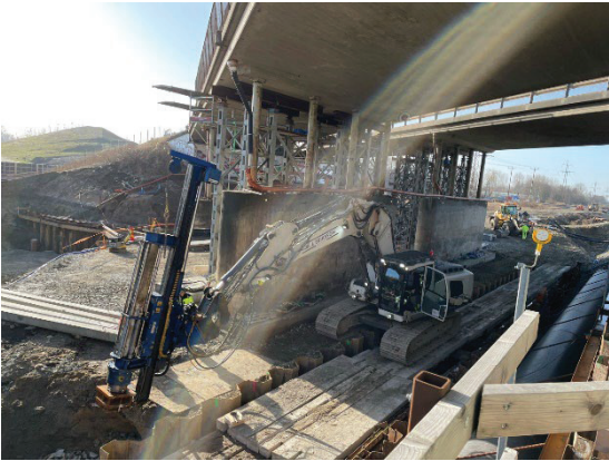
Figur 3. Maskin för pålinstallation placerad på stämp mellan spontväggar.
