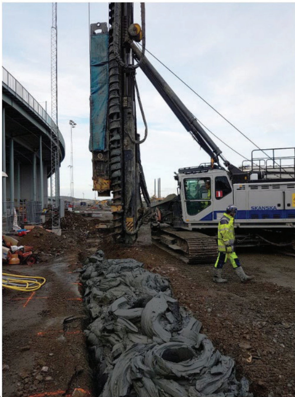
Figur 3 Arbete med att utföra slitsen längs med Göta älvbron
