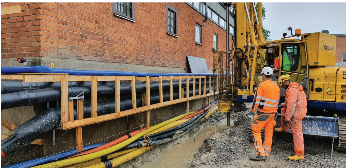
Figur 7. Pågående produktion av jetpelare.
