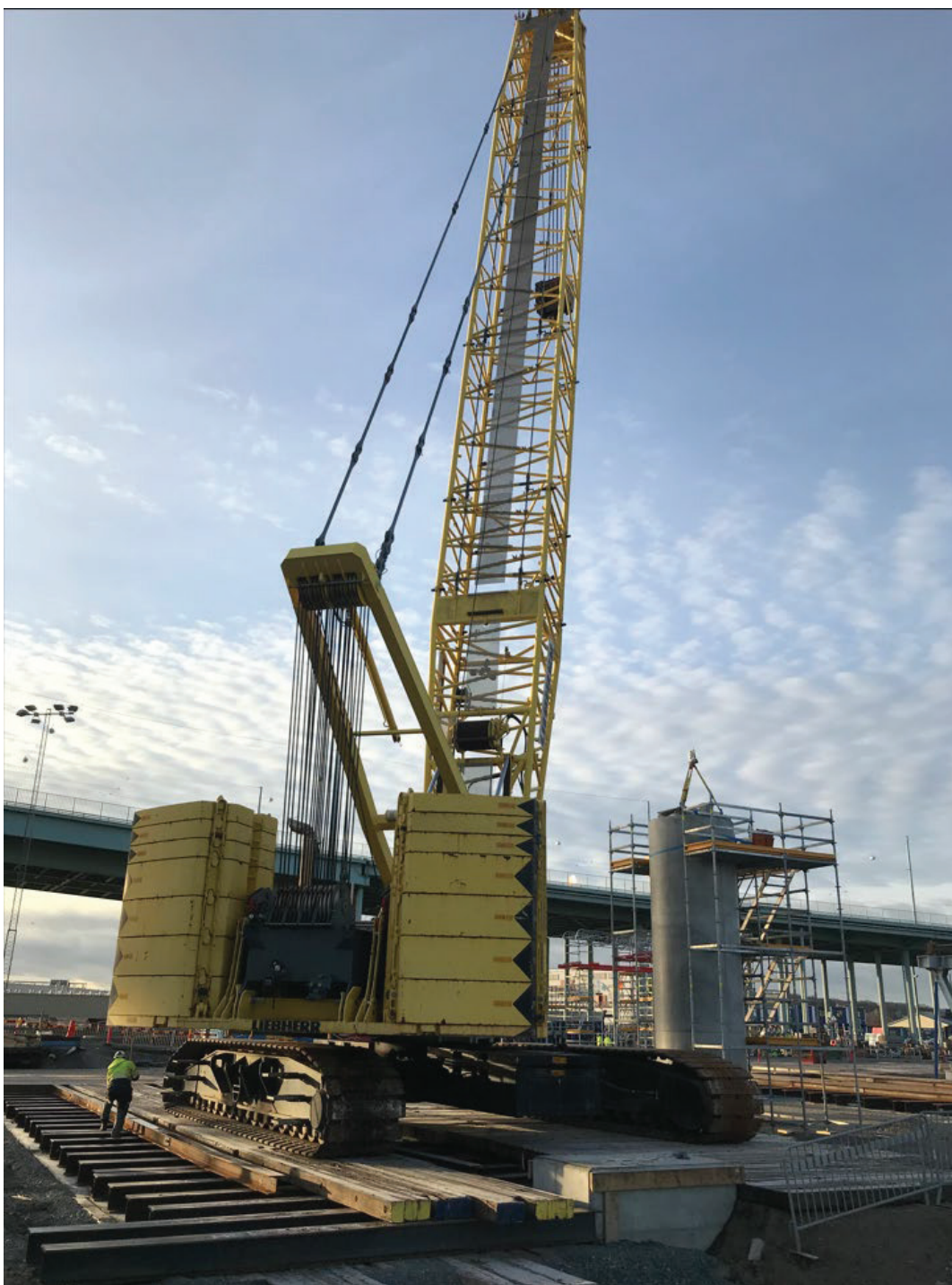
Figur 7 Larvkran Liebherr LR1300SX uppställd i nära anslutning till Göta älv.
