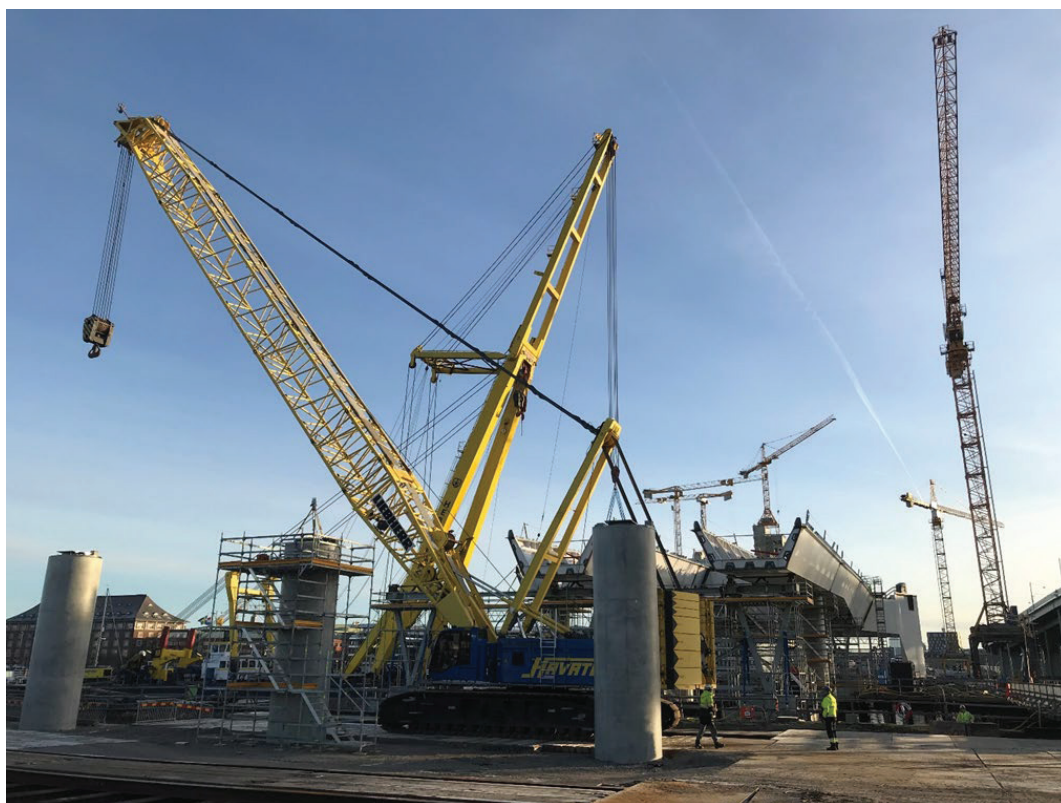
Figur 22 Larvkran, pontonkran och tornkranar samt monterade brobalkar över Göta älv. Fotot taget från NÄS och söderut mot södra älvstranden.
