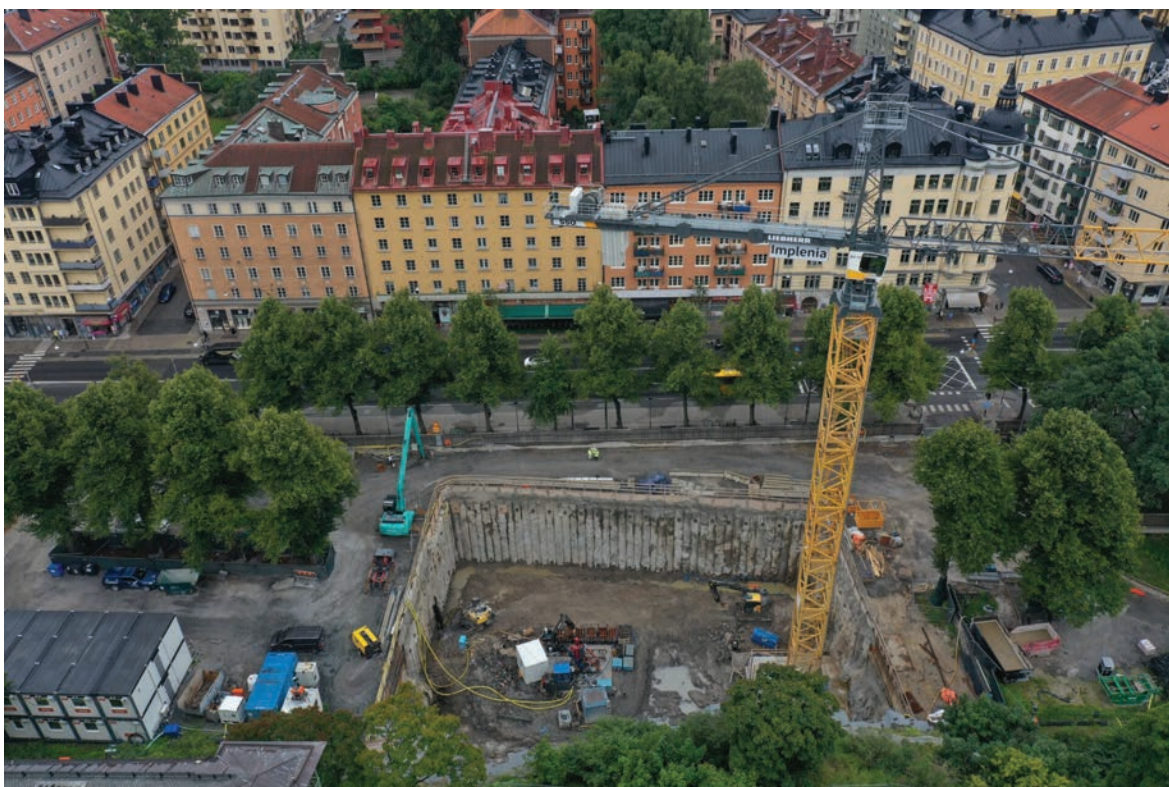
Figur 16 Bild visande tidpunkt för schakt ned till ankarnivå 2 samt pågående raise-borring för hisschakt.
