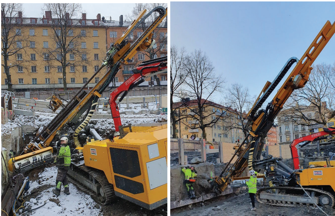
Figur 30 Bilder visande installation av stagförankringar.
