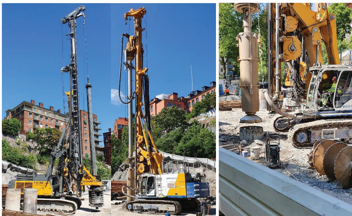
Figur 19 Maskin 1 (vänster) för neddrivning av foderrör till berg. Maskin 2 (höger) för inborrning av sekantpålarna i berg samt vid behov genomborrning av stora block.
