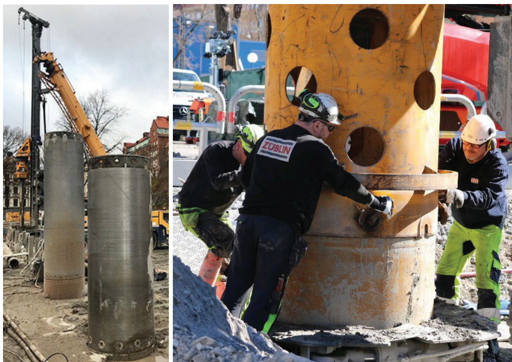
Figur 20 Borrhör för urschaktning av jord ned till bergöverytan.
