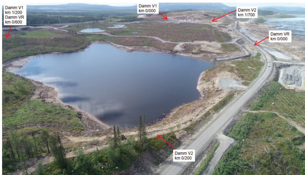
Figur 3. Drönarfoto över dammområdet, t.h. om vägen ser man den påbörjade byggnationen av damm V2. (Oscarsson, 2018).
