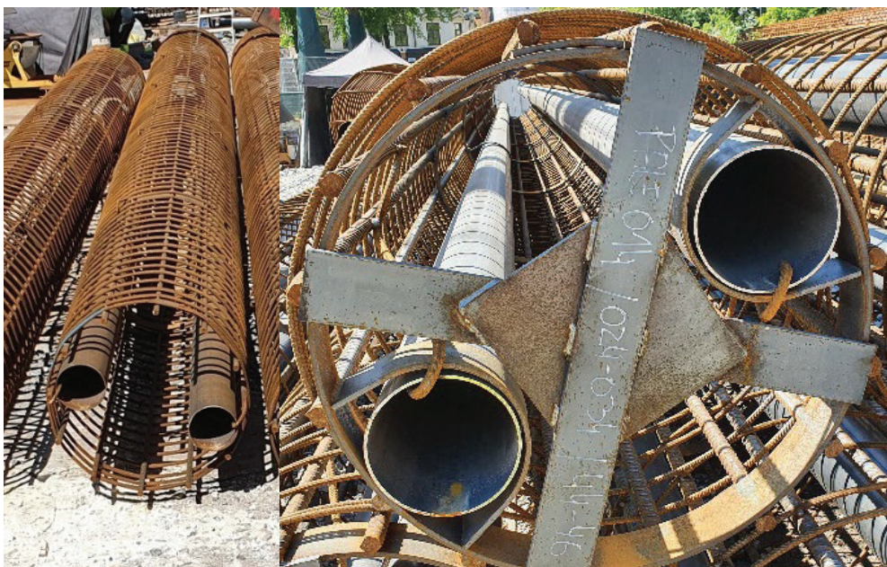
Figur 24 Armeringskorg till vänster och till höger botten av armeringskorg.
