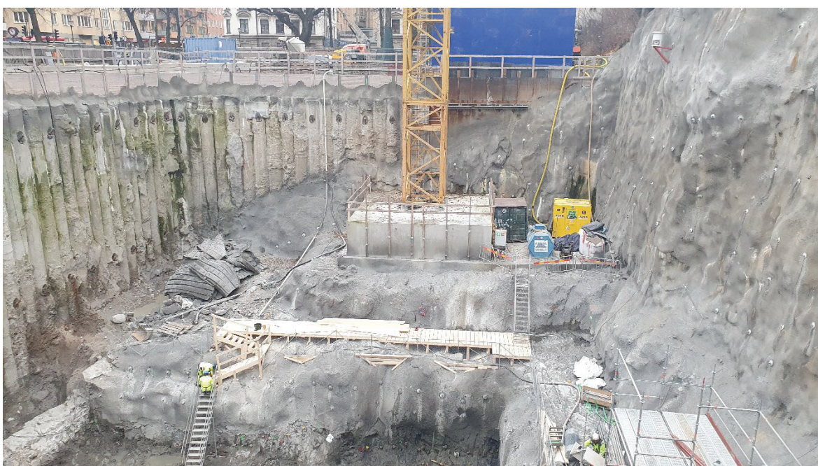
Figur 49 Bild av sekantpåleväggen utmed västra sidan och bergslänt utmed norra sidan inkl. den automatiska totalstationen för övervakning av sekantpåleväggen.
