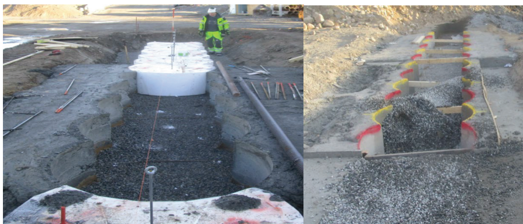
Figur 26 Exempel på typisk bormall för ansättning av respektive sekantpåle.
