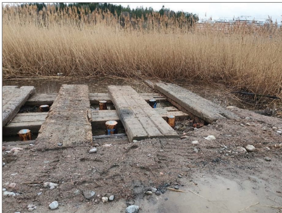
Figur 9. Installerade provpålar i område 2.
