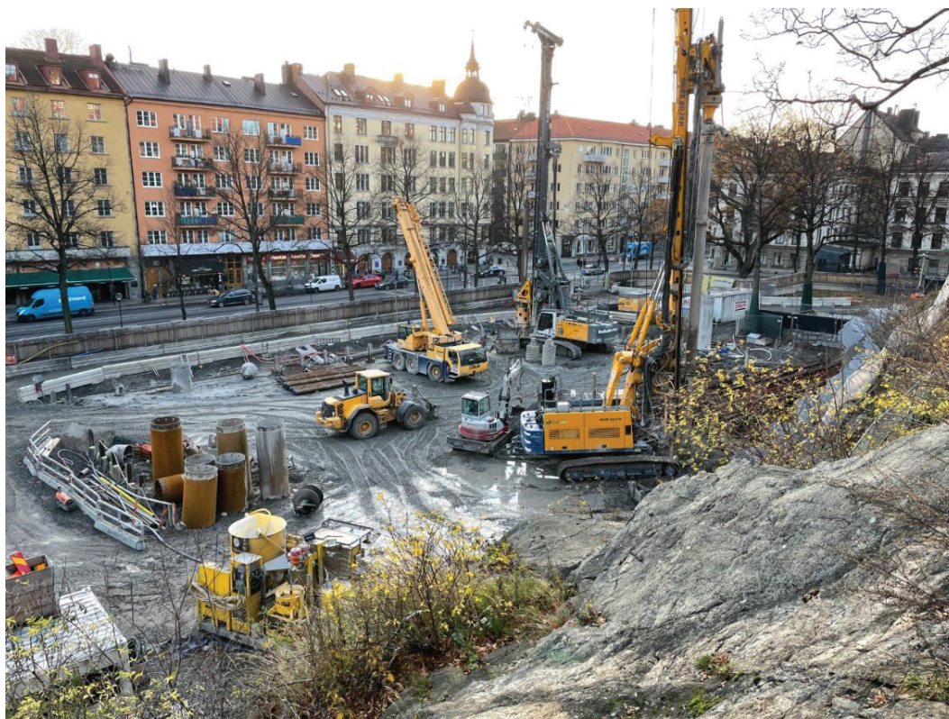
Figur 7 Arbetsområde och befintlig bergslänt utmed norra sidan.
