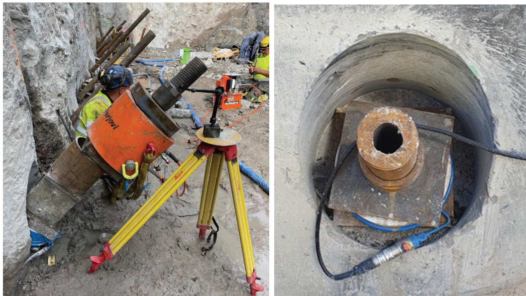
Figur 32 Godkännandeprovning på ankarnivå 2 och monterad stagkraftsgivare.
