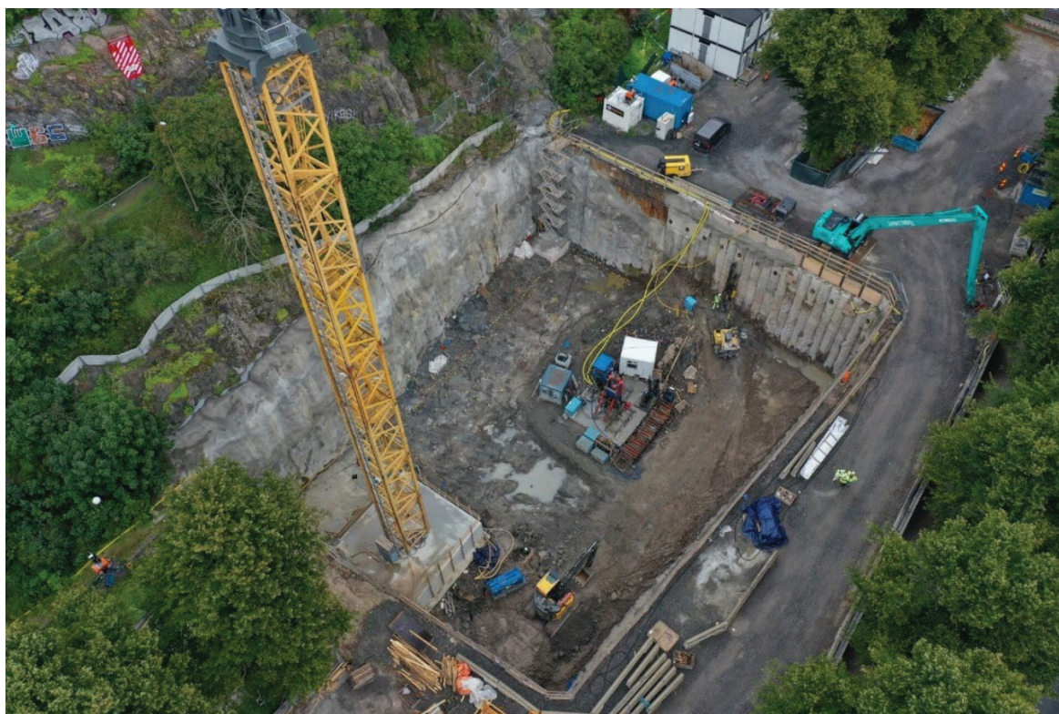
Figur 50 Bild av sekantpåleväggen vid tidpunkt för raiseborring för hisschakt.
