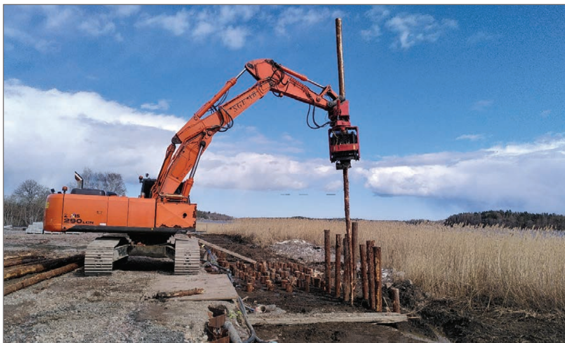
Figur 14. Första pålraderna installeras från kajlinje.
