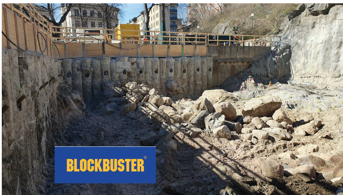
Figur 21 Bild visande omfattningen av stora block (>630 mm).
