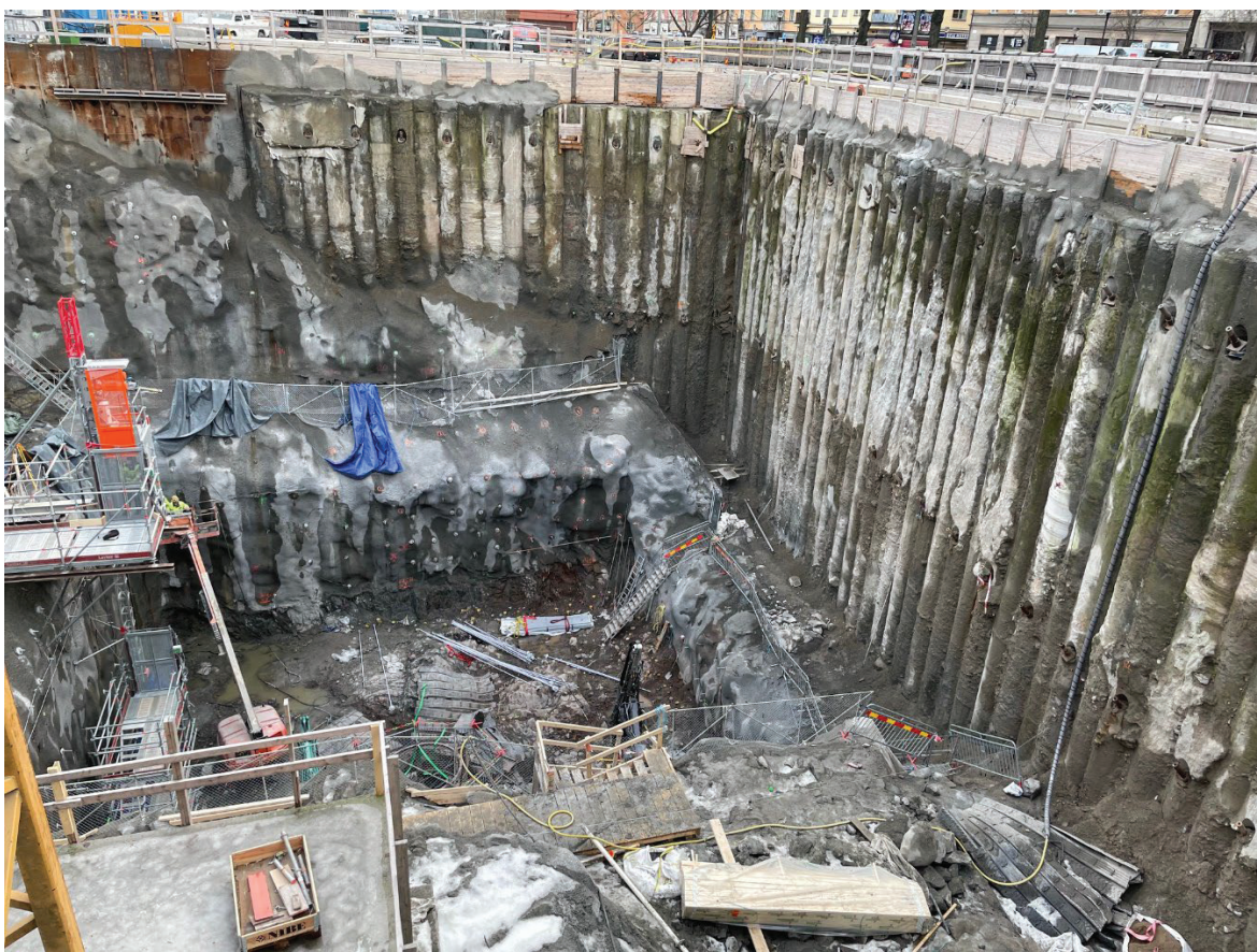
Figur 48 Bild av sekantpåleväggen utmed östra och södra sidan vid tidpunkt för avslutad schakt för stationsbyggnaden samt påbörjat berguttag för hisschaktet.
