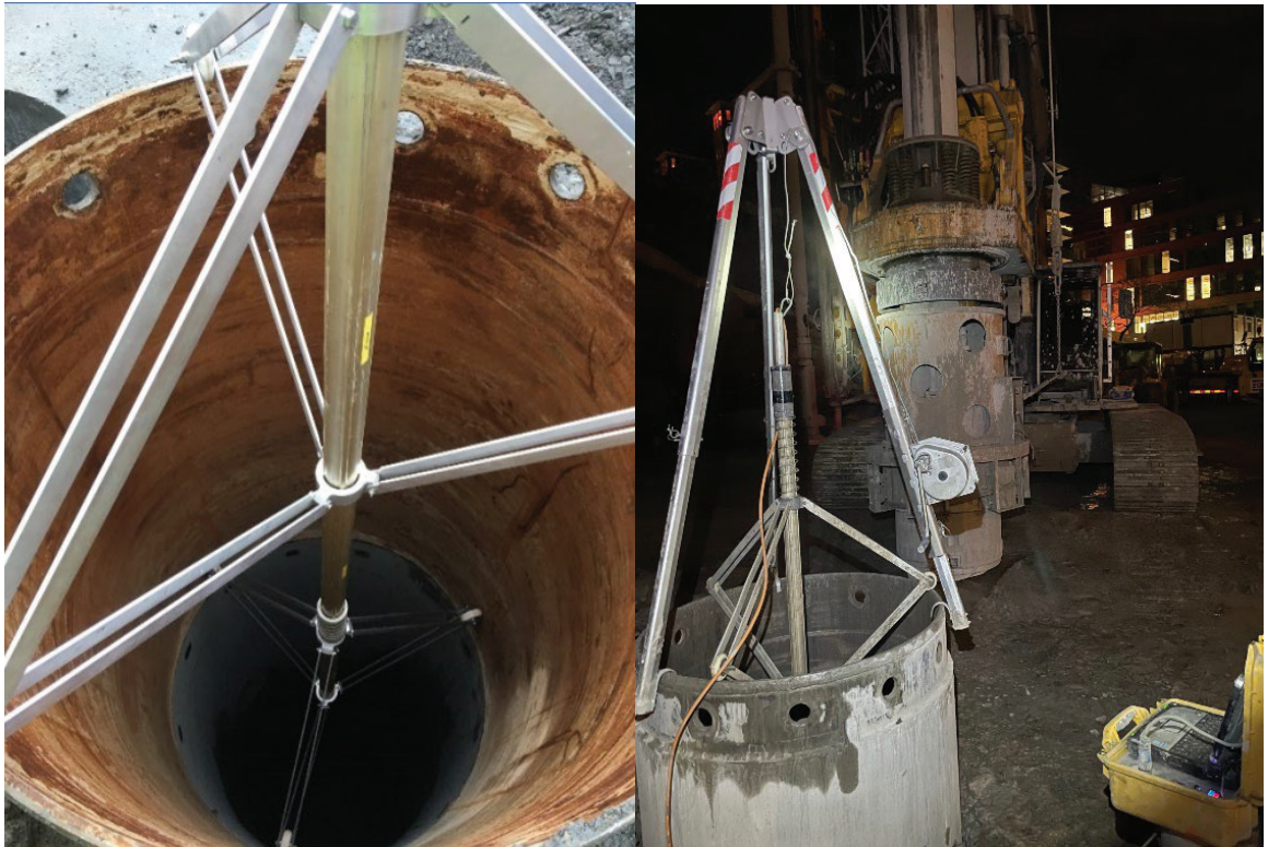
Figur 27 Inklinometermätning för kontroll av borrhingsavvikelse efter avslutad neddrivning av borrhöret.
